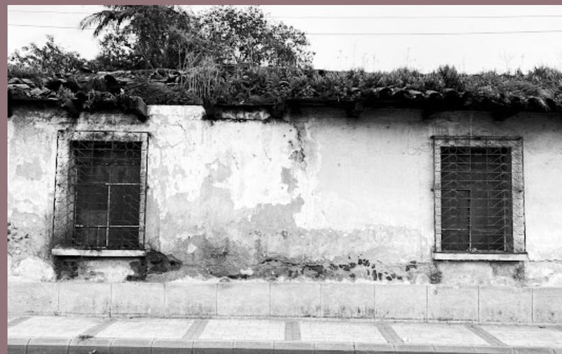
*Nota.* Se observa el deterioro y vulnerabilidad actual de la fachada principal con una cubierta descuidada y muros con el recubrimiento desgastado. Fuente: autor, D. Palencia (2021); colección personal Diana Palencia.
